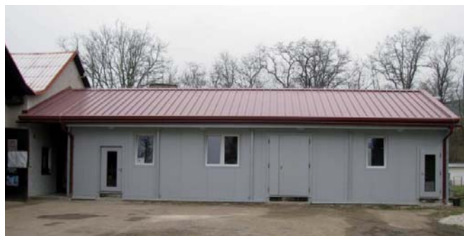
Objekt v Nedrahovicích nedaleko Sedlčan těsně před dokončením
