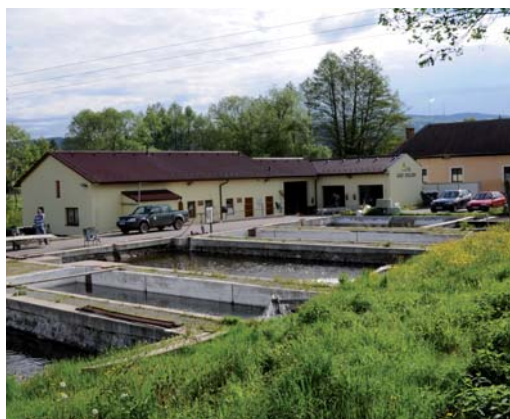
Rekonstruované sádky ve Chvalšínách (divize Horní Planá)
